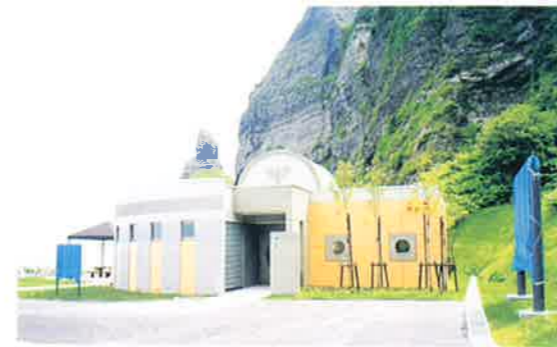
豊浜トンネル駐車帯(平10・3)
